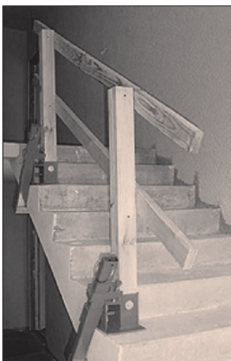
Fotografía: Safety Maker Inc.
